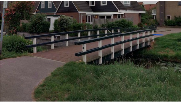
Brug 36 ( Julianadorp) Fietspad naast Zuidwal . Balken omdraaien vervangen dekconstructie
